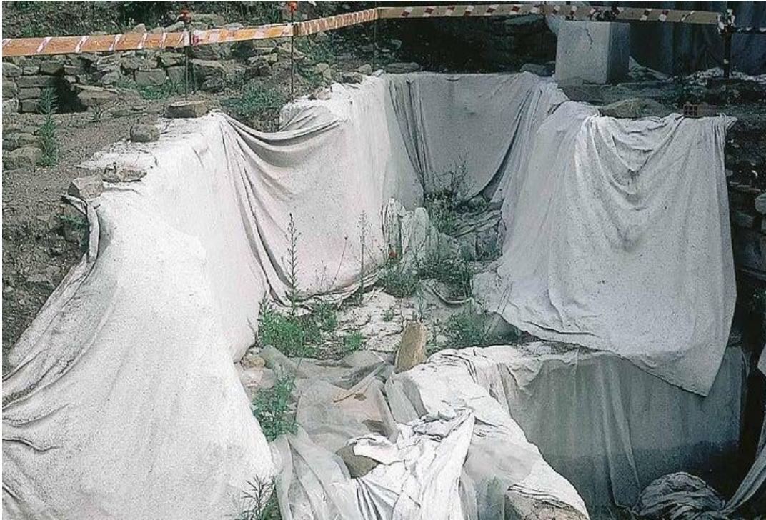
Fig. 4 – Esempio di protezione degli scavi mediante posa di geotessile non tessuto.
